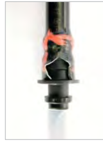
Montaj bölgesinde yırtılma
